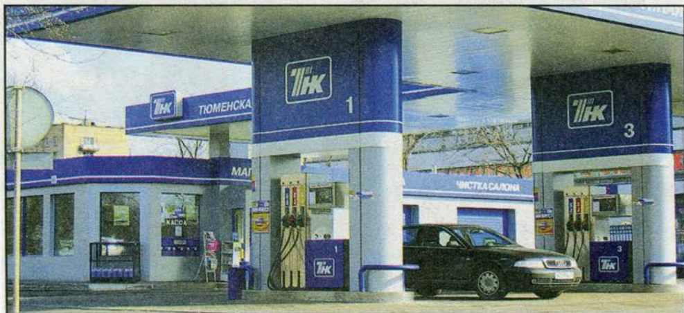
природный газ Автозаправочная станция
