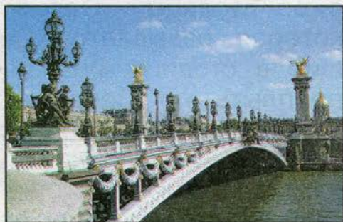
Мост Александра III
